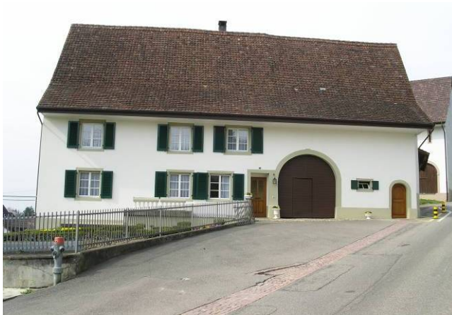
Abbildung 7 Gut erhaltenes ehemaliges Bauernhaus an der Juchgasse (Kulturobjekt Nr. 918)
